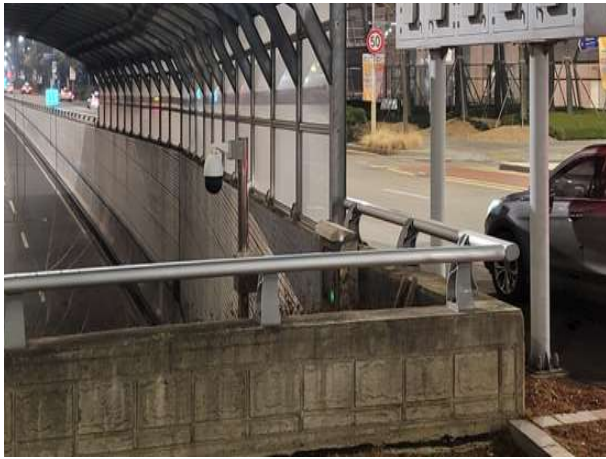
안전 및 기타시설(진입 접속부 가드레일) 상태현황
