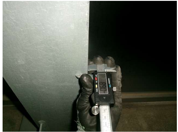
방음터널 부재치수 측정
