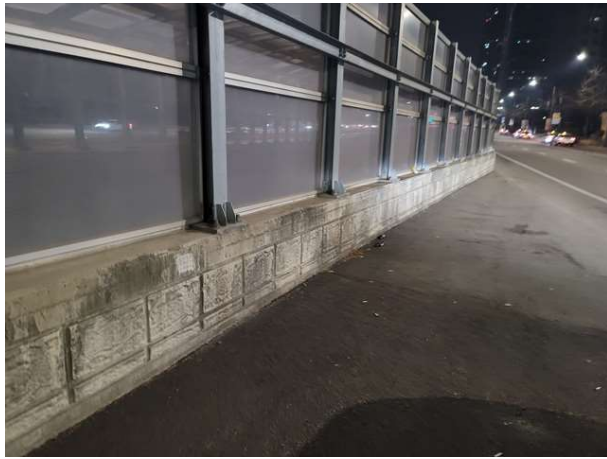
외부 기초콘크리트 전경
