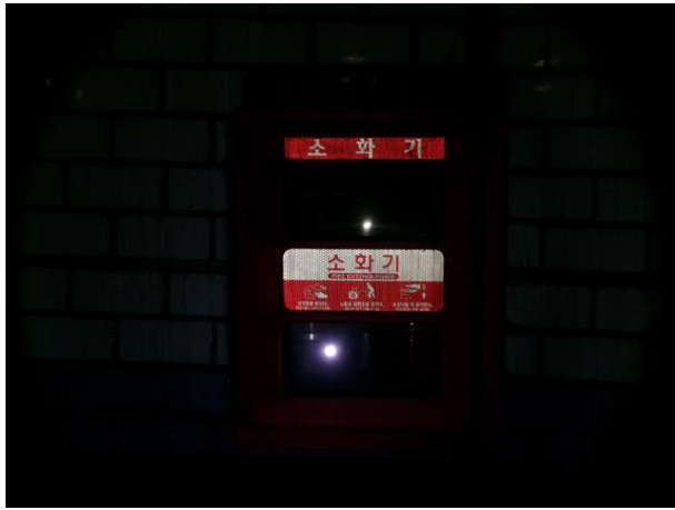
방재시설(소화기) S01 상태현황
