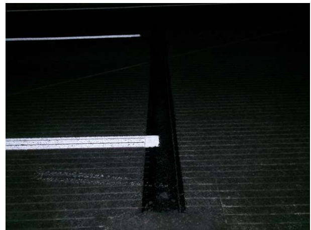
S2 도로부 신축이음부 상태현황
