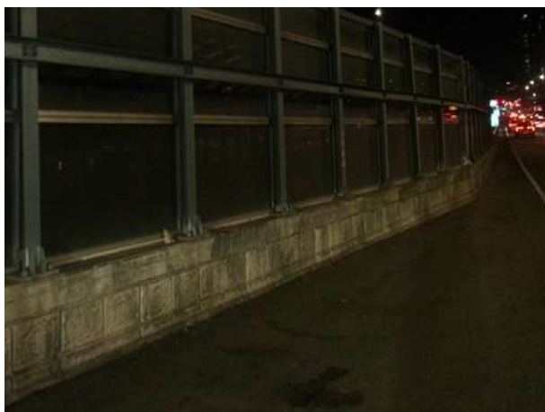
S2 기초콘크리트(좌) 상태현황
