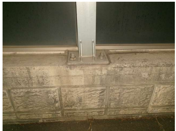
S1 기초연결부(좌) 상태현황
